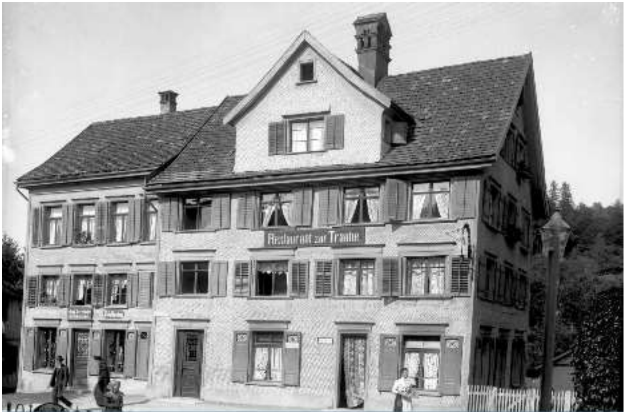
Außen-Ansicht des ehem. Rest. Taube (1900)
